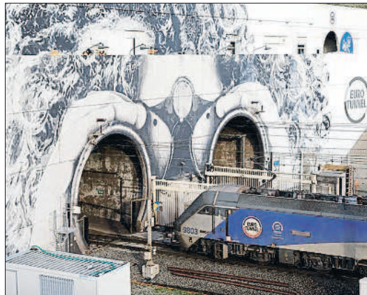
Boca francesa del túnel ferroviario bajo el canal de la Mancha
