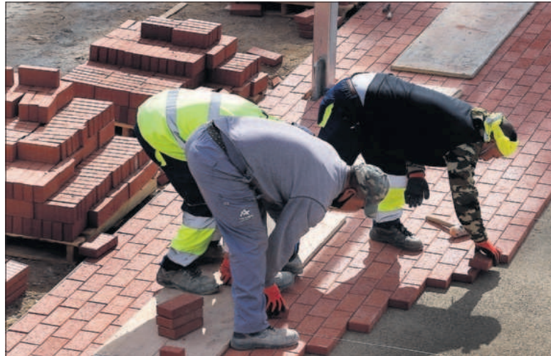
Trabajadores de la construcción en el puerto de Mataró. / CRISTÓBAL CASTRO
