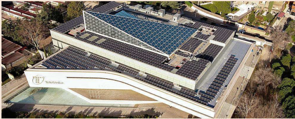
Los 2.000 metros cuadrados de paneles solares de la cubierta del centro de control de red (CNSO) de Aravaca (Madrid), producen 420 MWh al año de energía limpia. Ayudarán a cumplir con los objetivos de medio ambiente del grupo.
