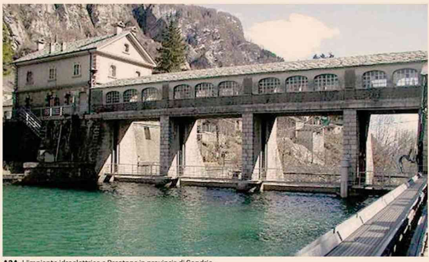
A2A. L'impianto idroelettrico a Prestone in provincia di Sondrio
