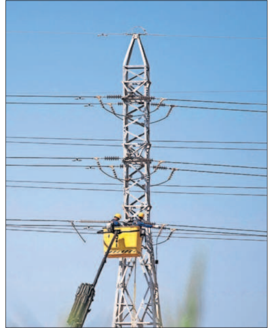
Trabajos en un tendido eléctrico de Sevilla, el jueves. / PACO PUENTES
