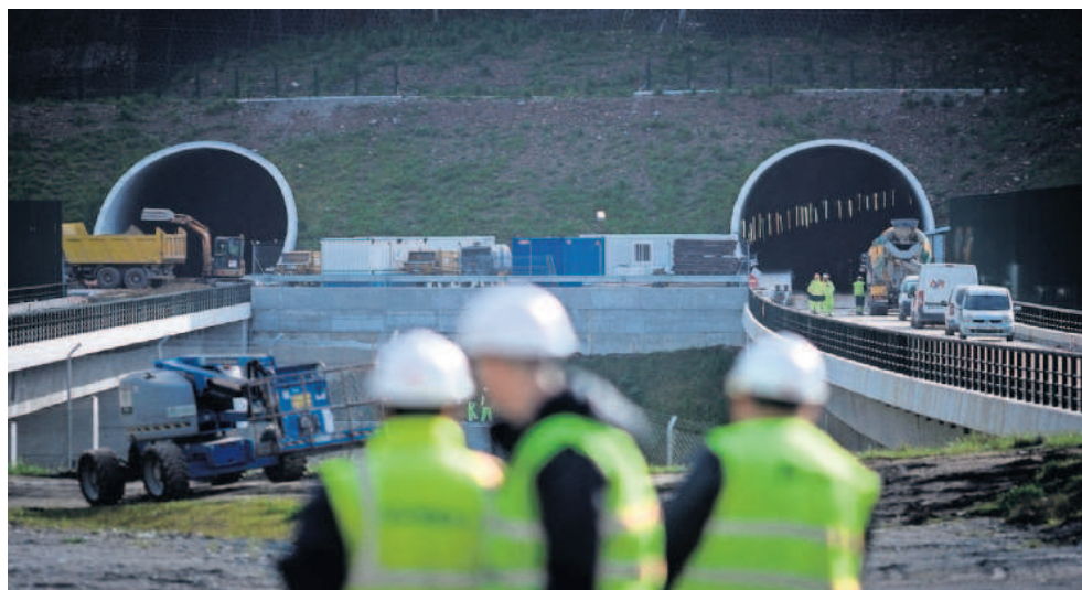
Obras de la vía en la línea de alta velocidad Madrid-Galicia. EFE
