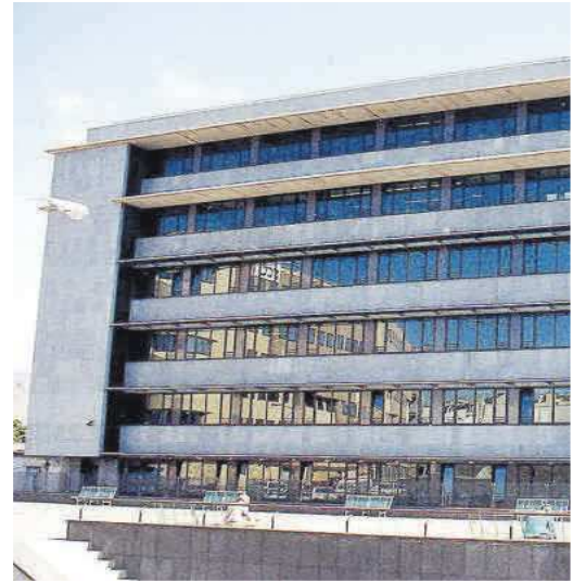
Edificio de Usos Múltiples II, en la capital. | E.D.
