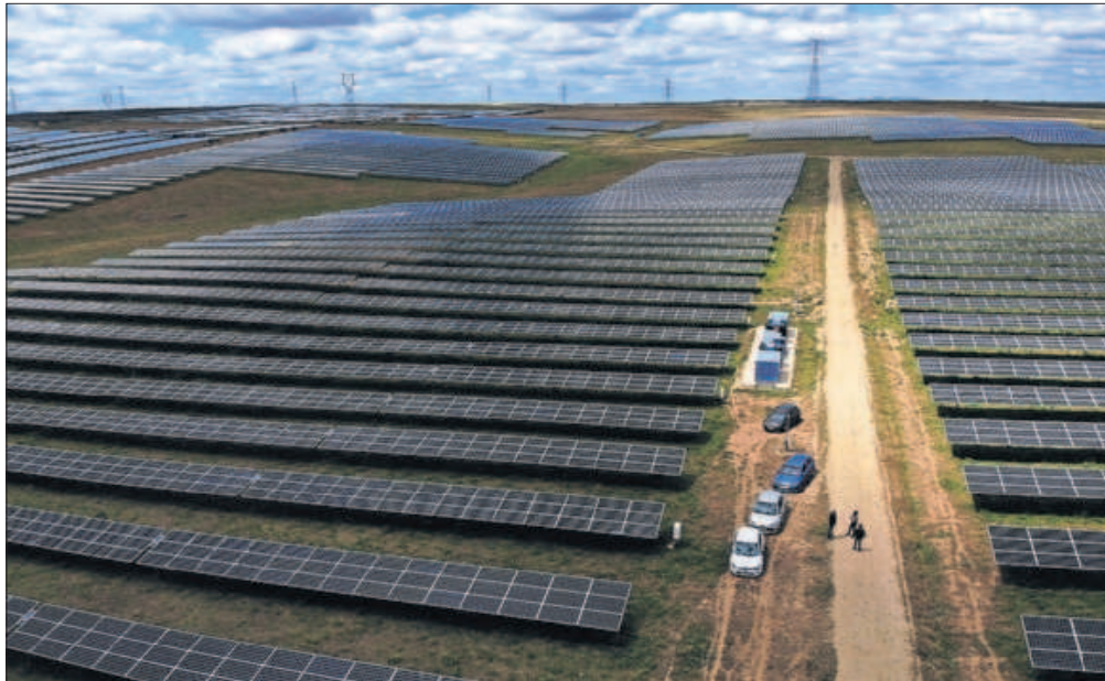
Instalaciones de una planta fotovoltaica en Trujillo (Cáceres). / PACO PUENTES
