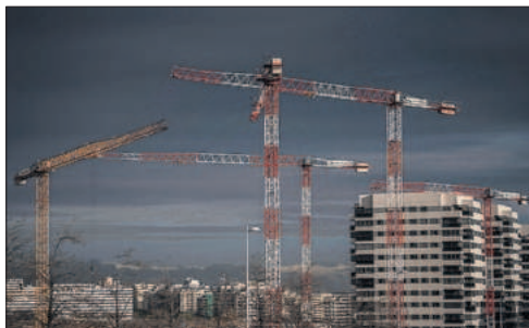
Edificios residenciales en construcción en Madrid. / OLMO CALVO
