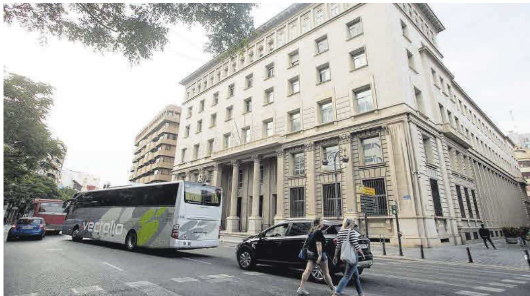
Fachada de la antigua Delegación de Hacienda de València, inaugurada en el año 1959 y cerrada en 2016.
