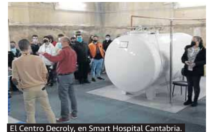
El Centro Decroly, en Smart Hospital Cantabria.
