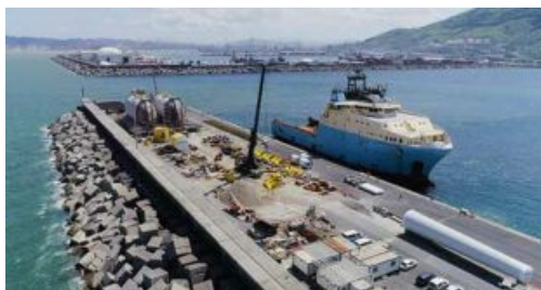
Se instala el sistema de fondeo de la plataforma flotante DemoSATH
