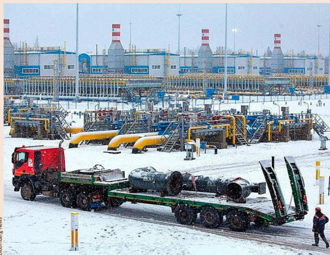
Instalaciones del gasoducto Nord Stream 2 en Ust-Luga (Rusia).
