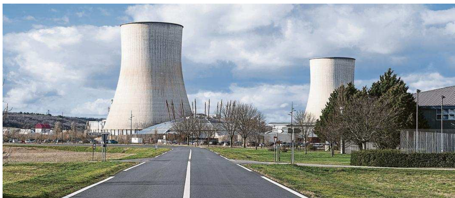
Sur les 28 réacteurs d'EDF à l'arrêt aujourd'hui, 12 sont à l'arrêt à cause de problèmes de corrosion. Photo Jean-François Fort/Hans Lucas via AFP
