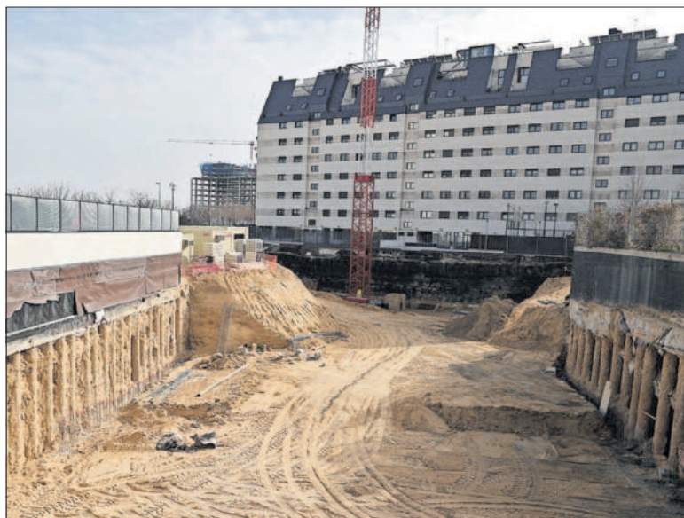
Edificio en construcción en Madrid, el pasado mes de febrero. / EDUARDO PARRA (EUROPA PRESS)
