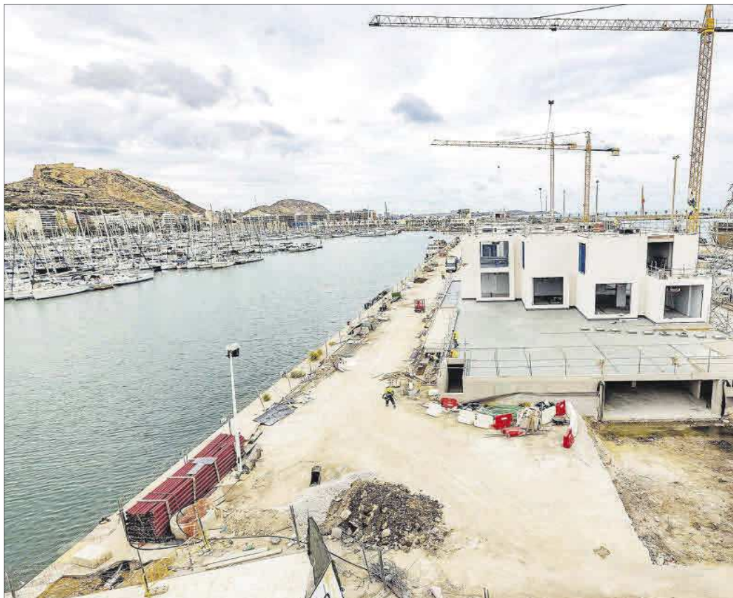
Operarios trabajando ayer en el muelle 5, donde se levanta el edificio de Distrito Digital en el puerto de Alicante.
